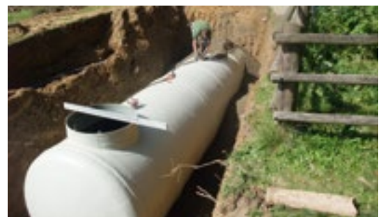
Einbau Trinkwasserspeicher
