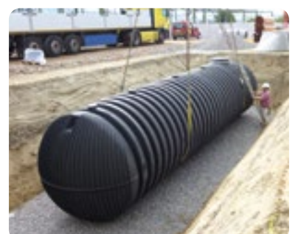
Löschwasserbehälter
