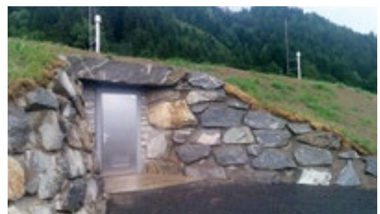
Zugangsbereich mit Steinschichtung
