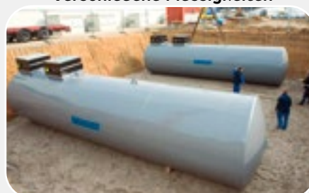
Doppelwandige Tanks für Benzin, Diesel und Heizöl
